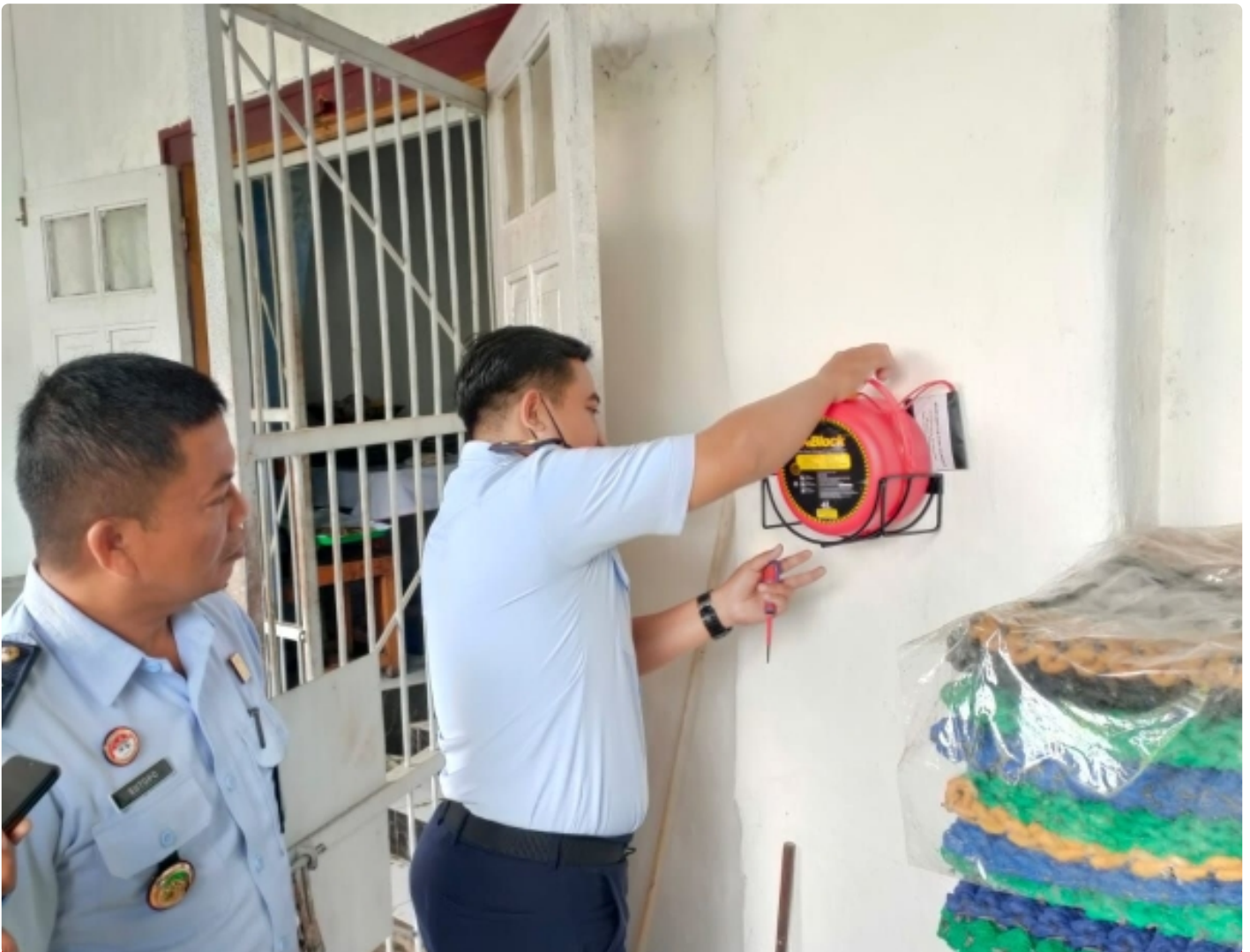
Antisipasi Kebakaran, Lapas Ambarawa lakukan Pemasangan APAR
